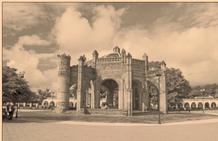
El estado continúa registrando importantes necesidades de inversión en infraestructura. FOTO: SHUTTERSTOCK
