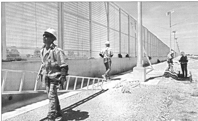
Trabajos para la nueva terminal aeroportuaria de la Ciudad de México en la carretera Peñón-Teixcoco ■ Foto Francisco Olivera/Archivo
